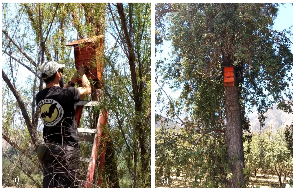
Figura 20. Instalación de caseta para murciélagos. a) proceso de instalación; b) caseta instalada.
