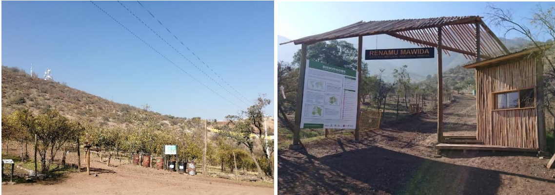
Figura 2. Antes y después del Proyecto Piloto en el acceso a la RENAMU Mawida
