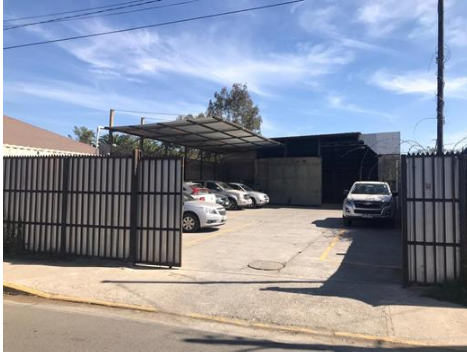
Figura 16. Vista exterior del galpón del estacionamiento de la Municipalidad de María Pinto. Fotografía: María José Valenzuela
