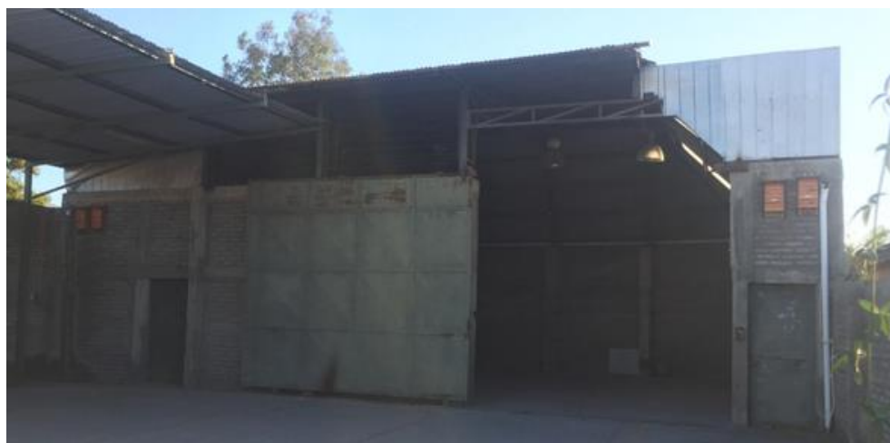
Figura 22. Vista frontal de galpón de estacionamiento con casetas instaladas en sus extremos laterales.
