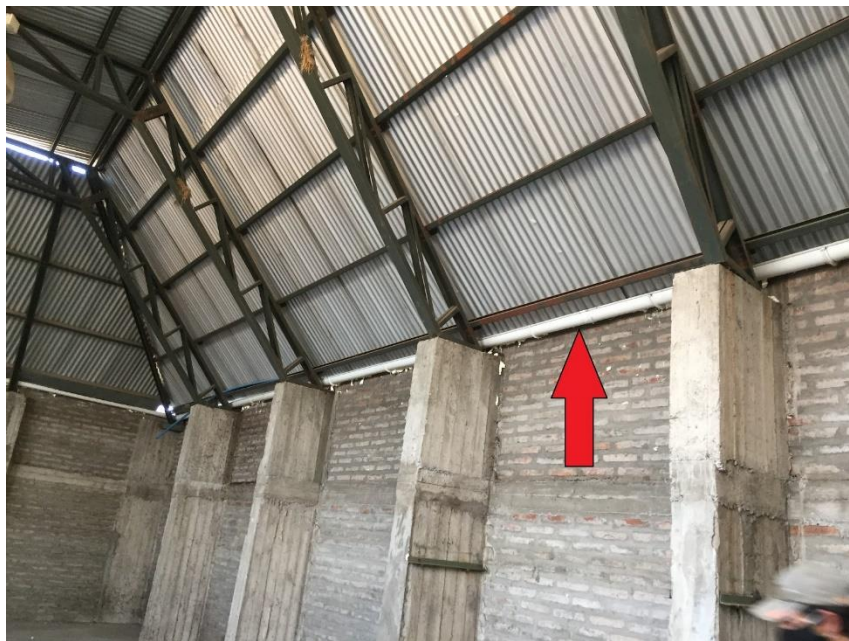
Figura 17. Vista interior del galpón del estacionamiento, donde se indica la estructura que refugia a los murciélagos. Fotografía: Ignacio Fernández.
