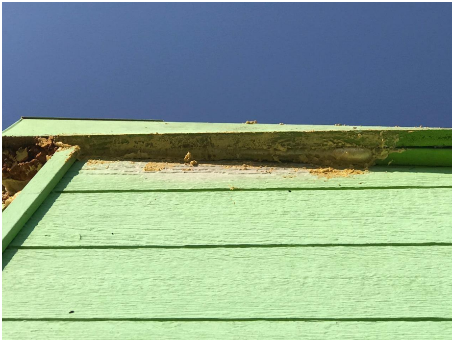
Figura 26. Sellado del espacio entre el techo y el muro en el jardín infantil Los Rulitos, lugar de acceso de la colonia de murciélagos.
