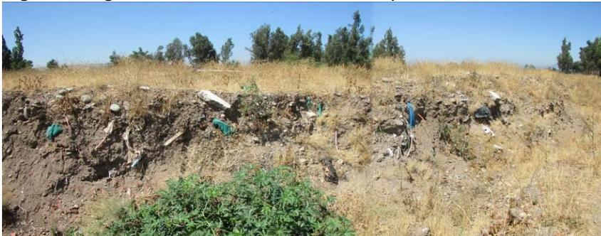
Relleno escombros funcionamiento faena extracción de áridos. Altura aprox del relleno, 4mt
