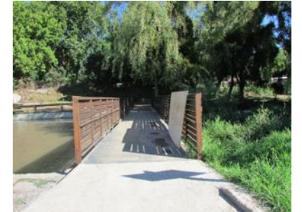
Remodelación Antiguo Puente histórico canal y balneario de Aguas Claras.
