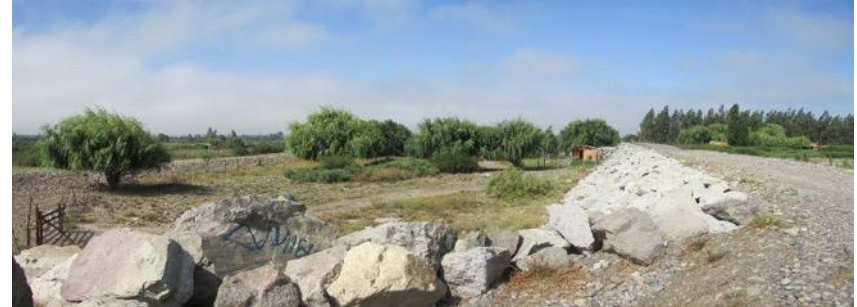
Pretel DOH – Vista hacia tomas de Terreno en zona de riesgo por inundación.
