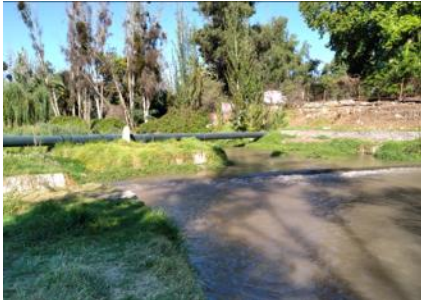
Presencia Acueducto de Aguas Servidas que atraviesa parte del Parque.
