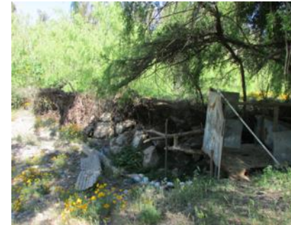
Construcciones ligeras para refugios temporalmente a orillas del río.
