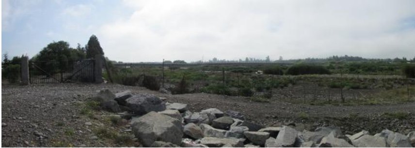
Puente San Francisco- bloqueo y cierre de accesos por tomas de terreno.
