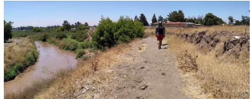
Vista canal regadío, huella peatonal y relleno de escombros.
